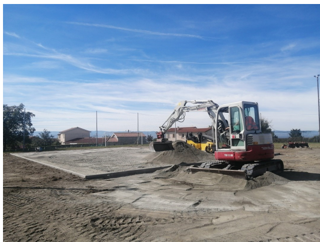
Les travaux de terrassement pour le city stade ont commencé lundi 25 septembre.
