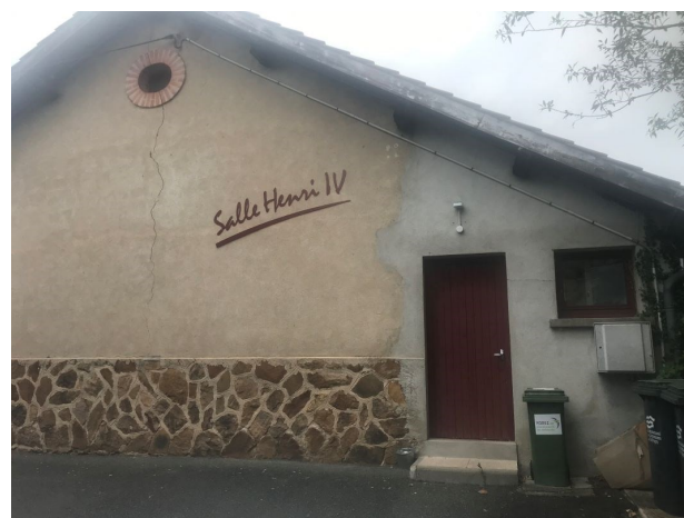
Une enseigne a été installée par Sébastien et Kenzo sur la façade de la salle Henri IV. Elle a été réalisée par l'entreprise BAM agencement
