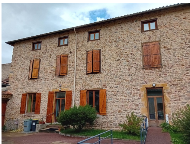
Les volets de la cure ont été repeint par l'entreprise nérondoise Bélérine . Kenzo et Philippe se sont chargés de peindre en noir les ferrures.
